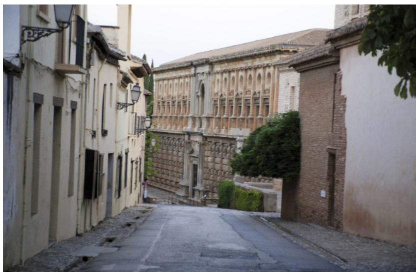
4. Fachada completa meridional del Palacio de Carlos V desde la Calle Real Alta.
