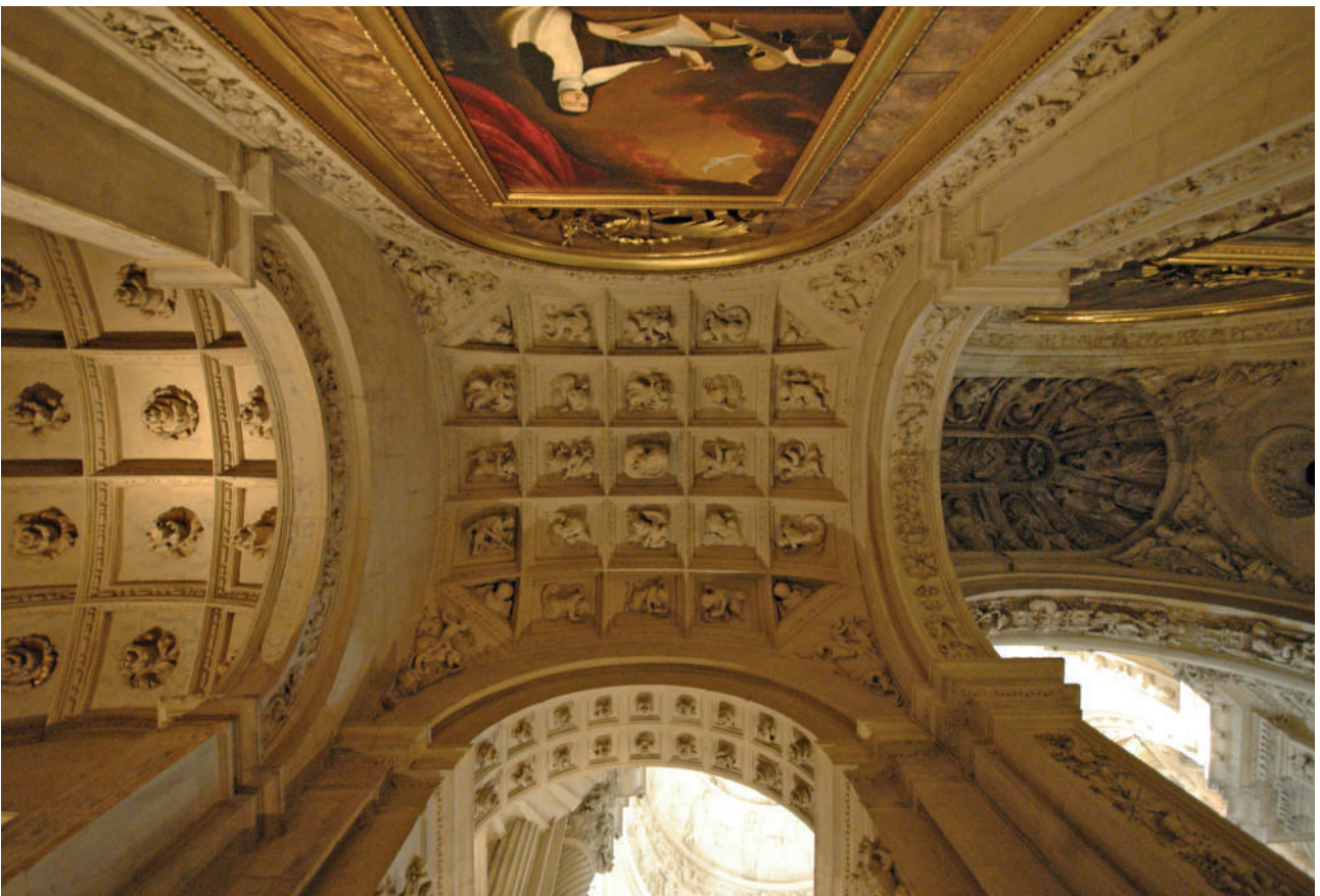
Fig. 2-6. Soluciones de abovedamiento de los tramos laterales de la cabecera de la sacristía mayor de la catedral de Sevilla. Diego de Riaño y Martín de Gáinza (1528-1543). Fotografía del autor
