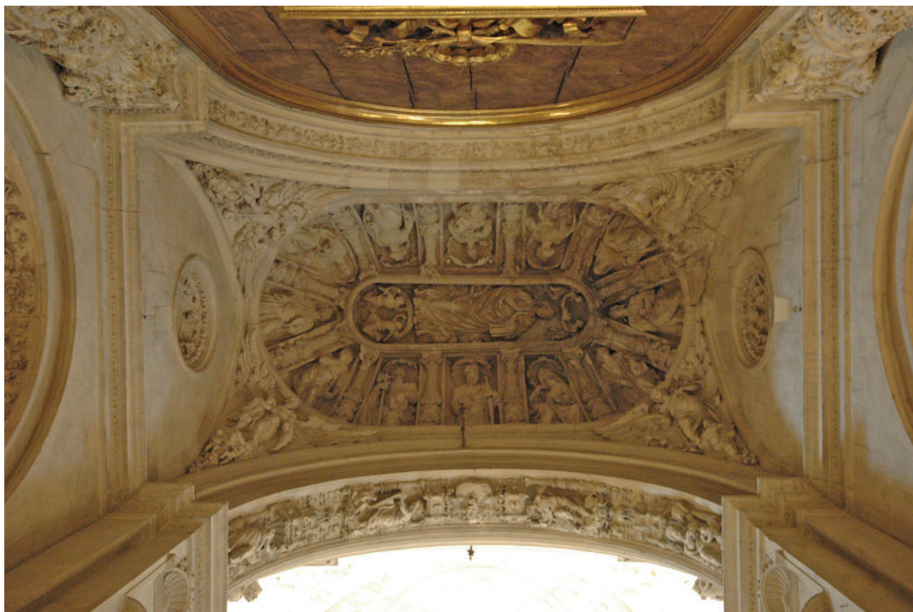
Fig. 2-7. Solución de abovedamiento del tramo central de la cabecera de la sacristía mayor de la catedral de Sevilla. Diego de Riaño y Martín de Gaínza (1528-1543). Fotografía del autor
